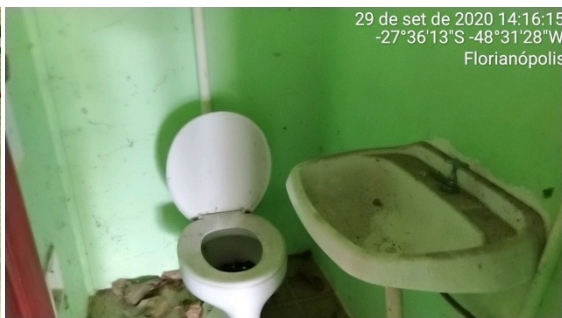
Imóvel - Interno - Banheiro
