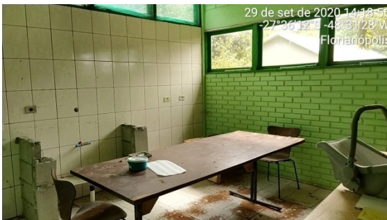
Imóvel - Interno - Refeitório
